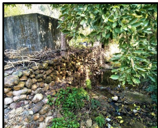
(d) Gabion sidewall
