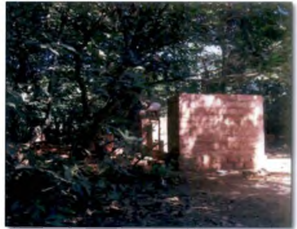
(d) Karakka Kavu (New construction)
